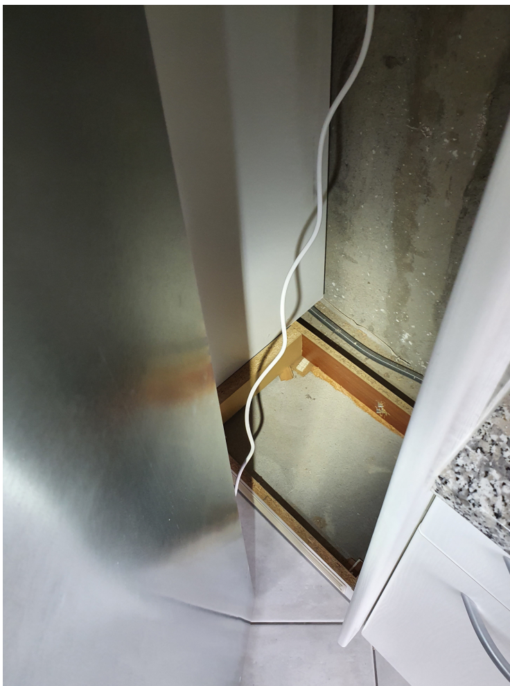
Abbildung 1: Der ausgebaute Kühlschrank und der Hohlraum dahinter.
